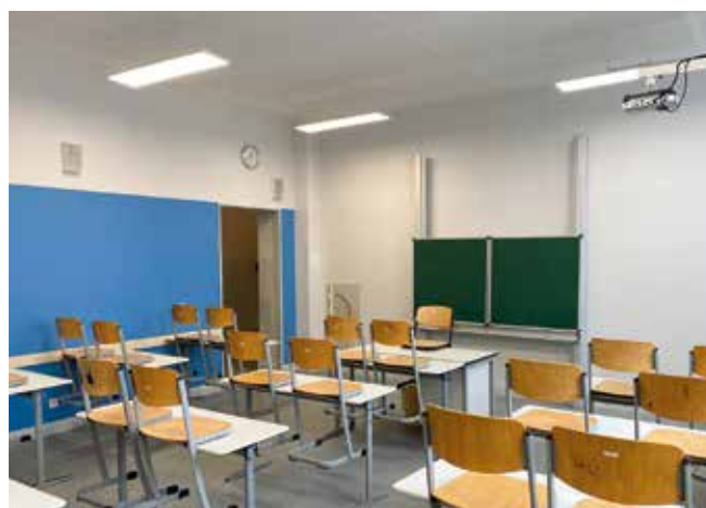
Einer der renovierten Klassenräume, der nicht nur eine neue Akustik-Decke und einen neuen Fußboden erhielt, sondern auch neue Lampen, deren Lichtfarbe angepasst werden kann.
