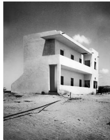
Nicht identifizierter Bau von Richard Kauffmann aus den 1930er Jahren
