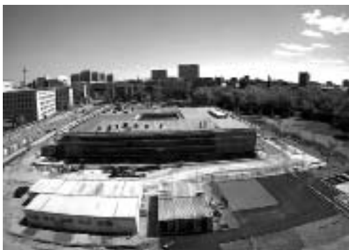
Eine Webcam zeigt das Baugeschehen am Gelände der »Topographie des Terrors«
