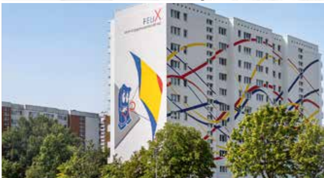
ADK 133-135 | WDV mit künstlerischer Gestaltung der Fassade
