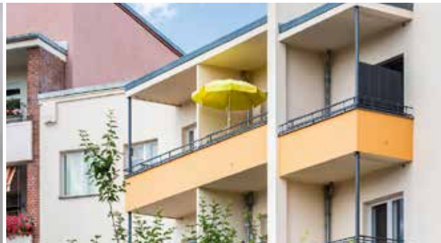
Tankredstraße 1-7, 9-15 | Putzarbeiten an der Fassade
